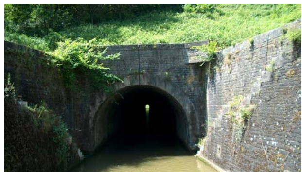
De 560 meter lange tunnel van Ham.
