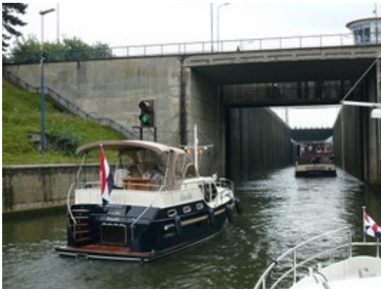
Sluis Petit Lanaye, de grens met België
